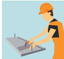
Aplicar el cemento cola en la base a colocar con una llanta dentada.
