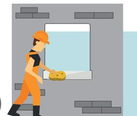
Una vez colocada la pieza limpiar con agua y dejar secar el cemento cola 24 horas.
