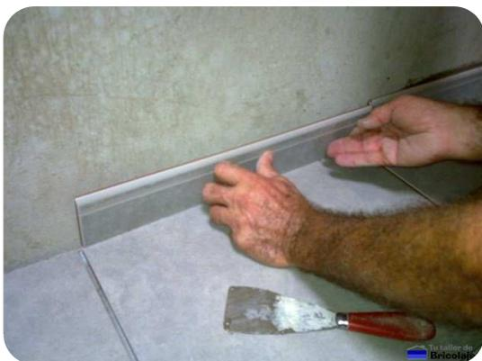
3. Colocar la pieza de rodapié en su lugar, haciendo presión de arriba hacia abajo de la pieza, tal que permita la unión de los cordones del material de agarre, y así conseguir que la pieza quedé totalmente maciza. Recortar el material sobrante. **NOTA: NO UTILIZAR NUNCA BORADA JA QUE NO ES FLEXIBLE!**
