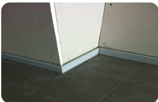
5. Para la colocación en esquinas se recomienda realizar corte a inglete en los extremos de las piezas para la consecución de un óptimo diseño y acabado del trabajo.
