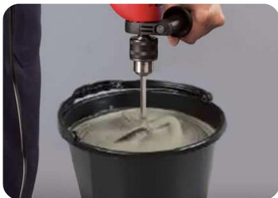
1. Preparar el material de agarre (cemento cola), usando 5 litros de agua aproximado por cada saco de 25 kg de cemento cola.
