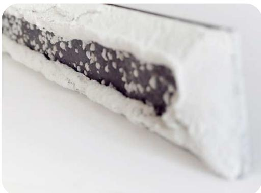
2. Aplicar el material de agarre a la pieza de rodapié por la parte de la arenilla, mediante la formación de dos cordones longitudinales en los extremos de arriba y abajo de la pieza.
